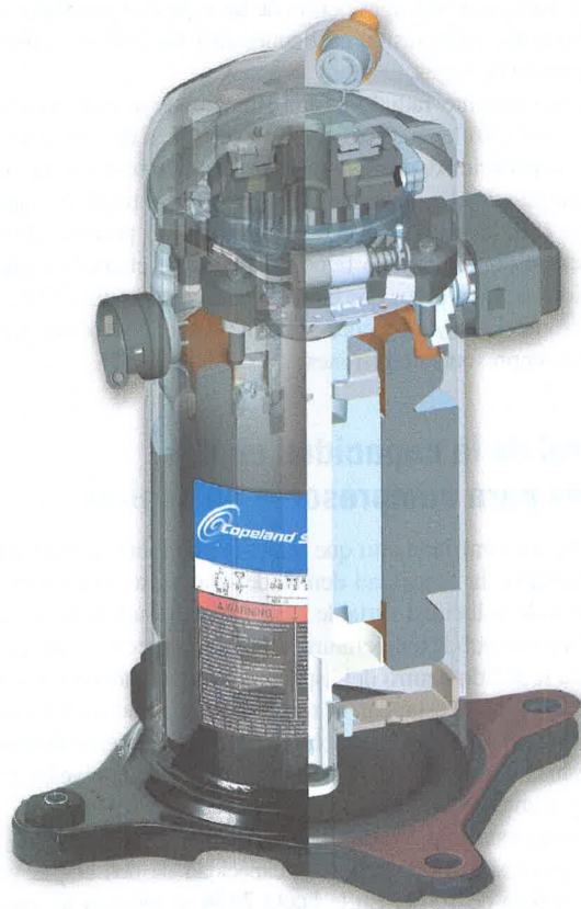
Figura 23-54 Compresor en espiral moderno de dos etapas con capacidad de modulación a 100% o bien a 67%. Cortesía de Emerson Climate Technologies
