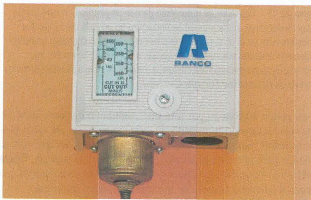
Figura 22-37 Dispositivo de control del ciclo del ventilador de un condensador. Este control realiza la misma acción (entra en funcionamiento debido a una subida de la presión) que el control de baja presión, excepto que funciona a un rango mucho más amplio. Fotografía de Bill Johnson
