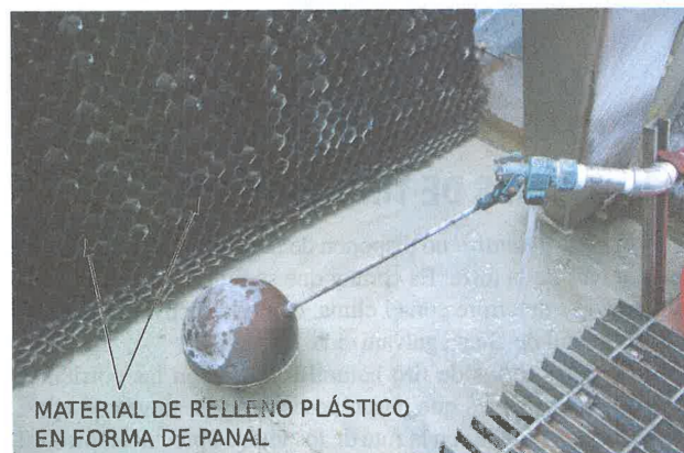
Figura 22-17 (A) Sistema de agua de reposición en una torre de enfriamiento. Como el desempeño de la torre de enfriamiento depende en parte de la evaporación del agua de la torre, se requiere de esta reposición. (B) Agua de reposición con el conjunto de flotador y válvula de agua. En el fondo se aprecia el material de relleno plástico en forma de panal. Cortesía de la Ferris State University. Fotografía de John Tomczyk
