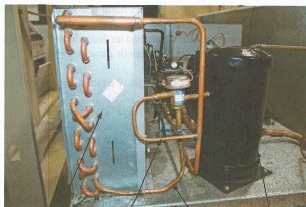
Figura 22-48 Válvula de control de la presión de carga de control de ambiente bajo (LAC) que se muestra conectada a un condensador y receptor. Cortesía de la Ferris State University. Fotografía de John Tomczyk
