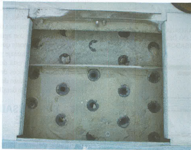
Figura 22-22 (A) Agujeros calibrados en la parte superior de una torre de tiro inducido. Los agujeros distribuyen el agua sobre el material de relleno que está más abajo que los agujeros. (B) Los agujeros calibrados en la parte superior de una torre de enfriamiento que presentan depósitos significativos de minerales que bloquean el flujo de agua hacia el material de relleno. Cortesía de la Ferris State University. Fotografía de John Tomczyk
